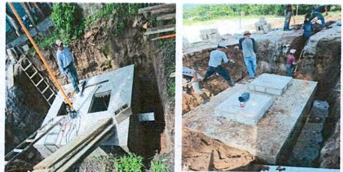
Foto 12: Construcción de nueva de fosa séptica
