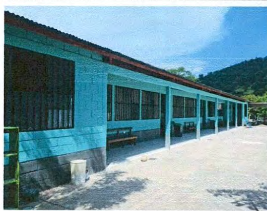
Foto 2: Pintura de muros exterior e interior
