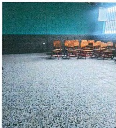
Foto 1: colocación de 275 m2 de piso de granito
