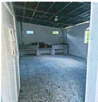
Foto 5: Repello en área de cocina
