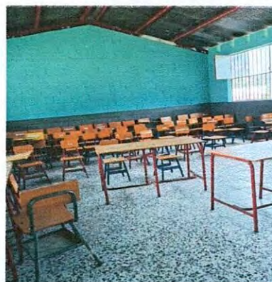
Foto 6: Pintura de muro interior de las aulas
