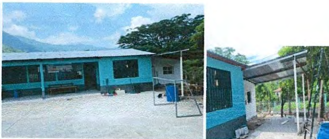
Foto 11: Mejoramiento de techo de la escuela, cambio de lámina en área de Dirección, cocina y área de comedor
